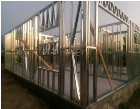
Montaje en Obra
